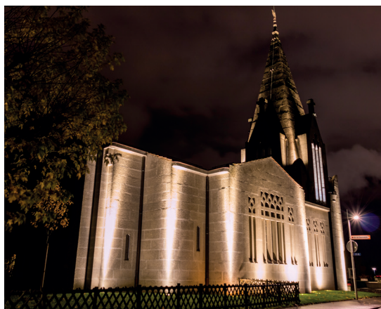
Eclairage de l'Eglise de Chantemerle par des luminaires LED
