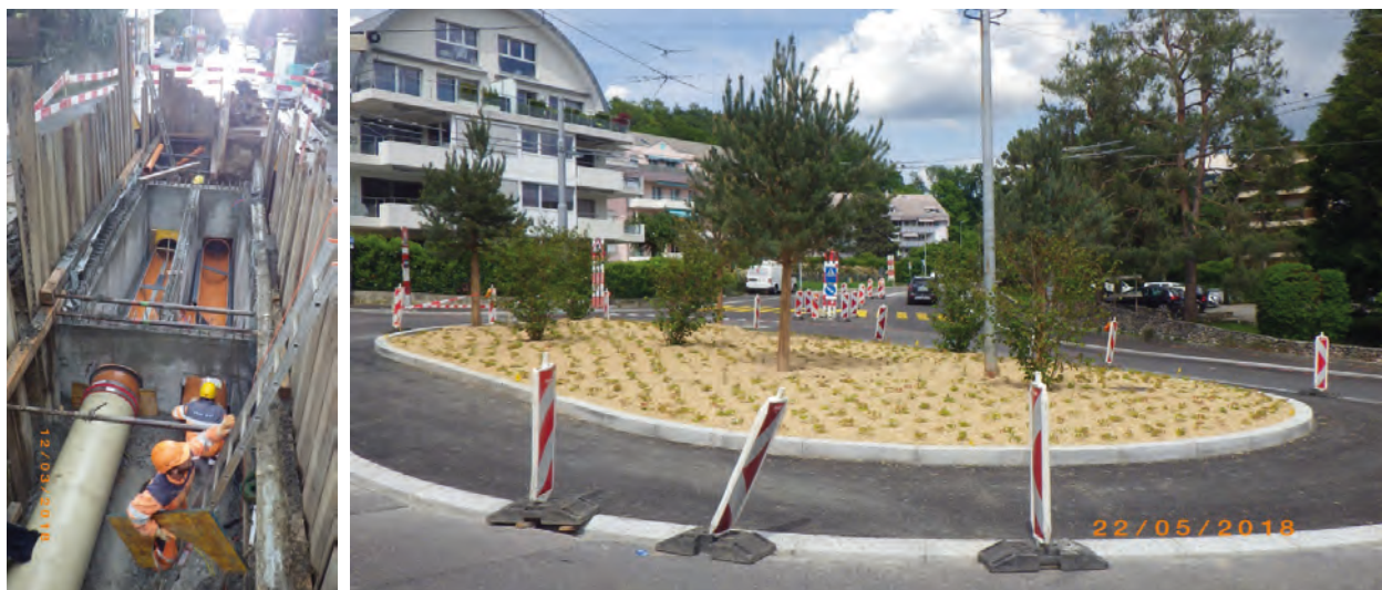
Ouvrage hydraulique à l'av. de la Rosiaz
