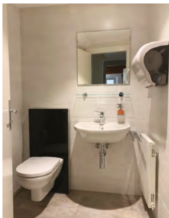
Reymondin 1, rénovation des deux wc
