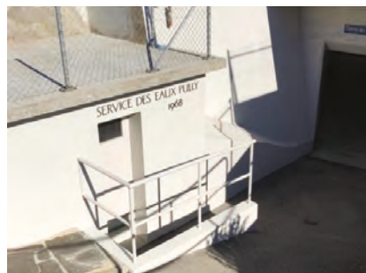
Passage sous voies ch. du Caudoz, rénovation complète des peintures et application d'un traitement anti-tags
