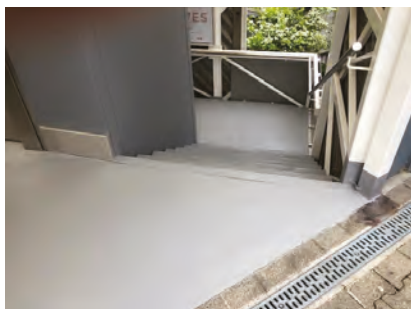
Ascenseur Verdaine, réfection du sol des escaliers
