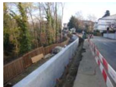
Voile de soutènement en béton
