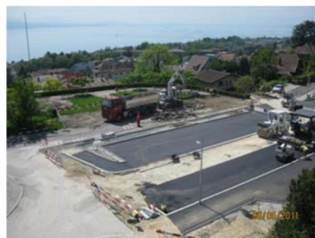
Pose d'enrobé à la pl. de Chantemerle
