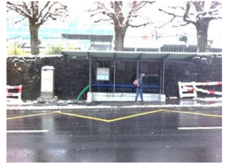
Abribus Préau Nord (décembre 2011)
