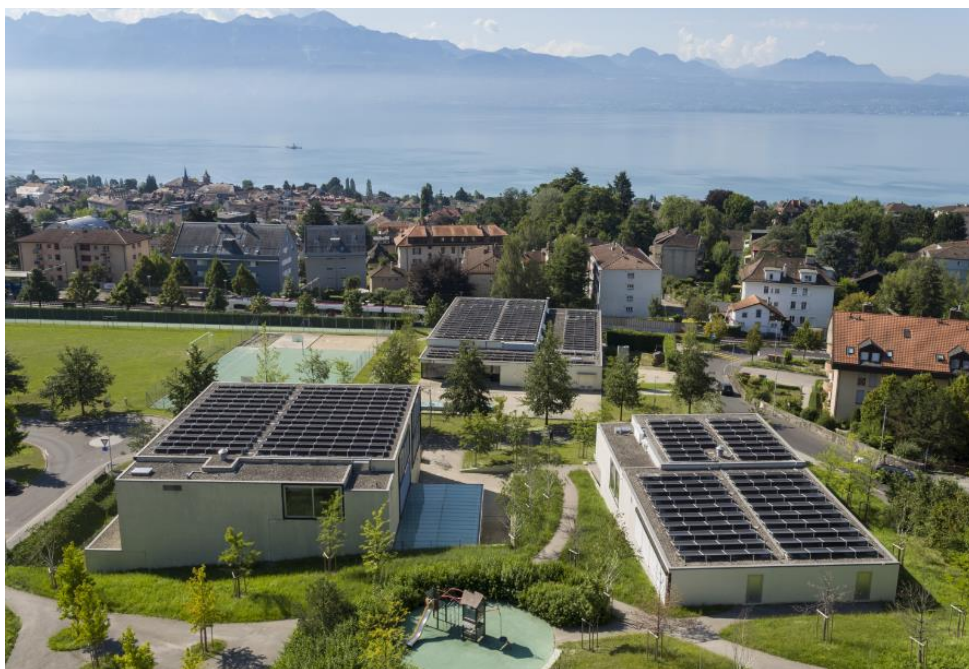
Réalisation communale exemplaire : collège des Alpes Installation photovoltaïque de 141 kW et chauffage à distance au bois
