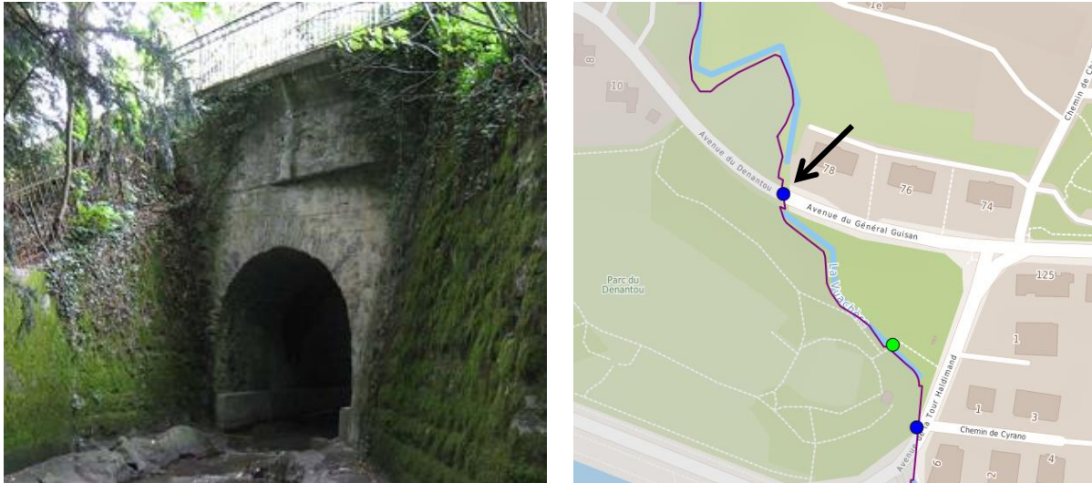
Photo et plan de situation du voûtage de la Vuachère, av. Général Guisan
