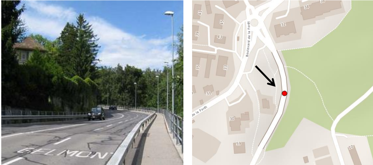
Photo et plan de situation du pont routier, ch. de Rennier
