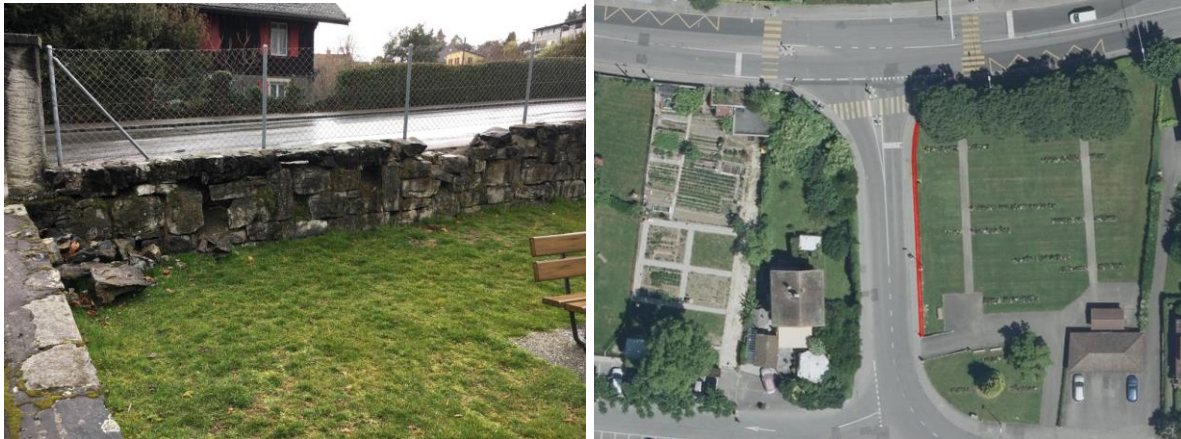
Photo et plan de situation du mur de soutènement de la rte du Port
