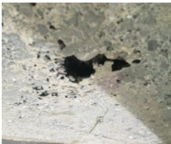
Figure 2 : défauts dans la structure de la paroi intérieure du digesteur primaire
