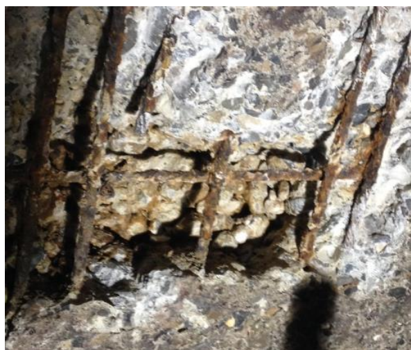
Figure 2 : défauts dans la structure de la paroi intérieure du digesteur primaire
