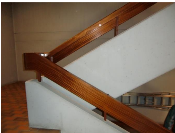
garde-corps de la cage d'escalier
