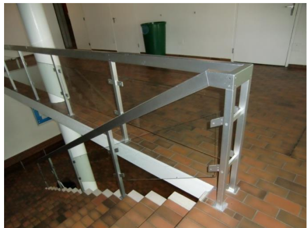
garde-corps de la galerie
