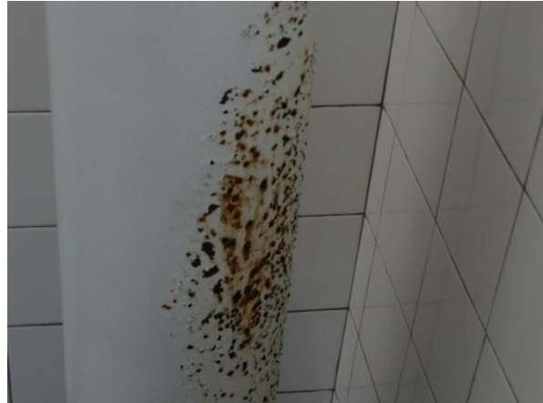
mortier colle amiante et pilier oxydé
