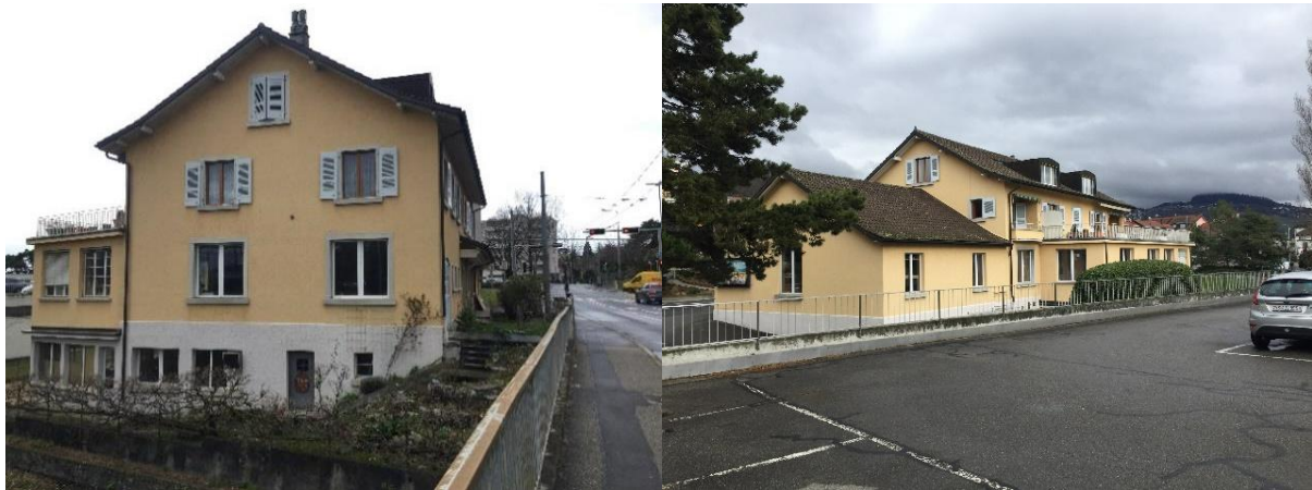
Photos de la menuiserie désaffectée au rez-de-chaussée et du logement à l'étage
