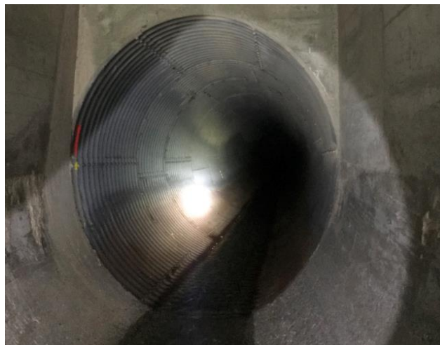
Entrée amont de la galerie
