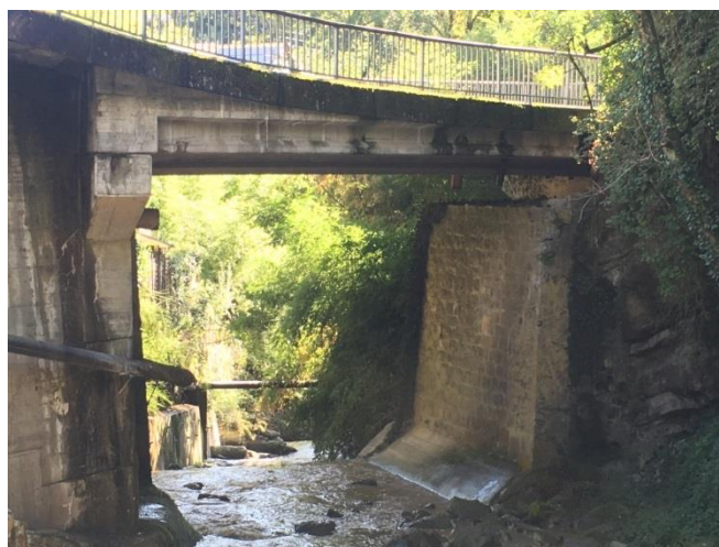
Pont sur la Paudèze - Vue générale
