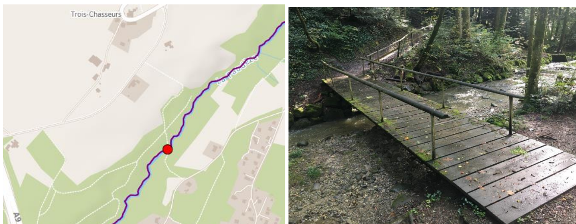
Situation et vue générale de la passerelle actuelle
