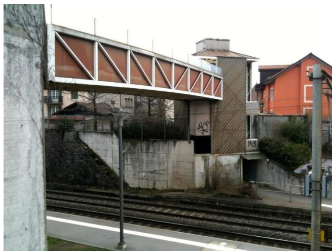
Vue sur la passerelle Verdaine
