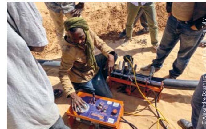
Employé de Nouakchott procédant à une soudure de conduite sur un chantier.
