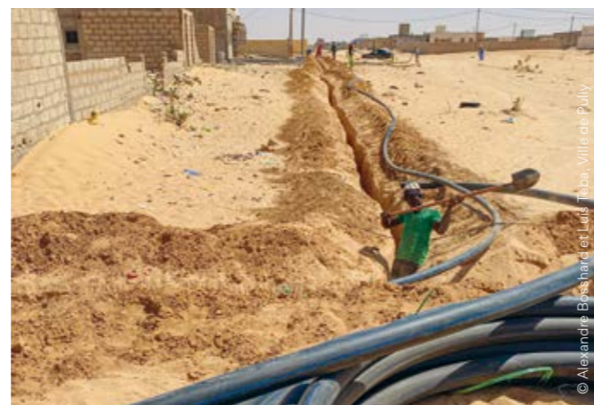
Pose de conduite à Nouakchott.
