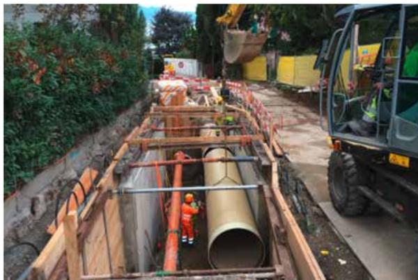
Pose du collecteur de récolte d'eau claire DN 1200 mm et d'eau usée DN 315 mm au ch. de Villardin
