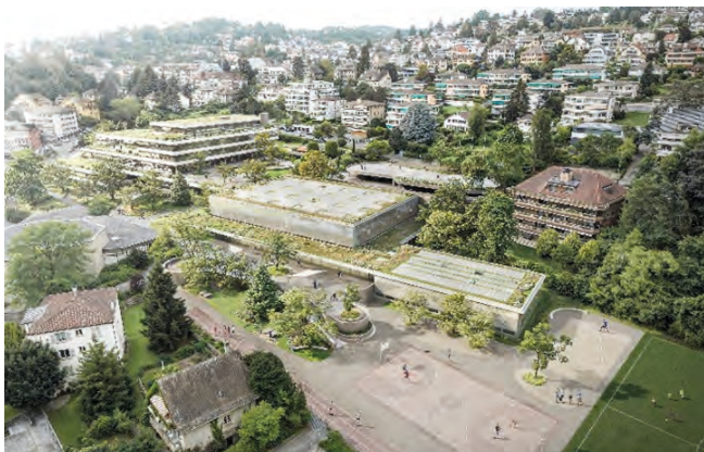
Collège Arnold Reymond - Vue aérienne 3D
