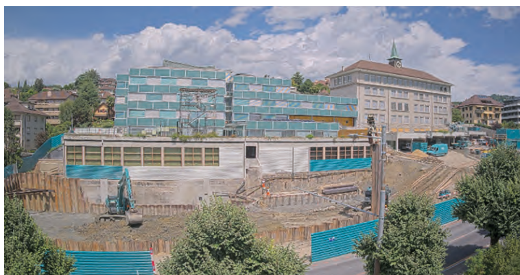
Collège Principal - Chantier
