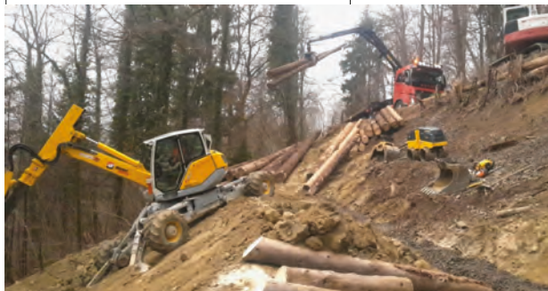
Construction du caisson à l'est du viaduc
