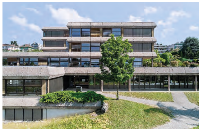
Collège Arnold Reymond - Façade existante sud
