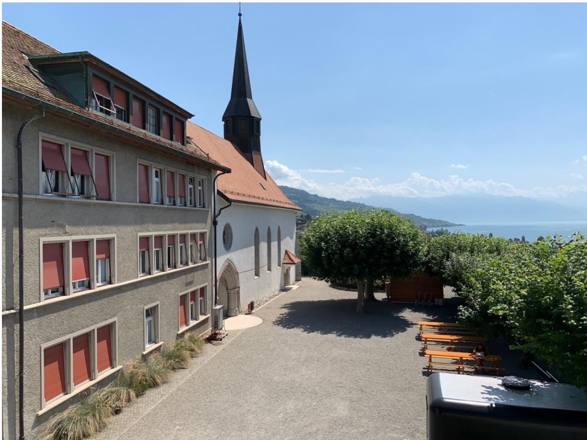
Bâtiment administratif sud (Prieuré 2)
