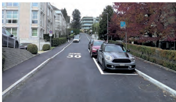
Vues avant et après les travaux du ch. de Tourronde depuis l'av. Général Guisan
