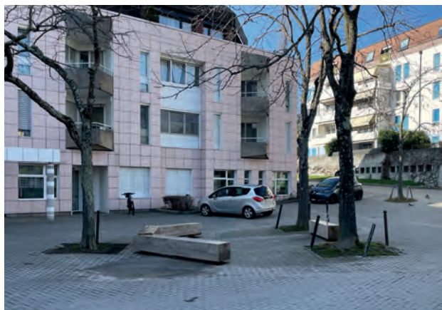
Dépavage Pré de la Tour avant
