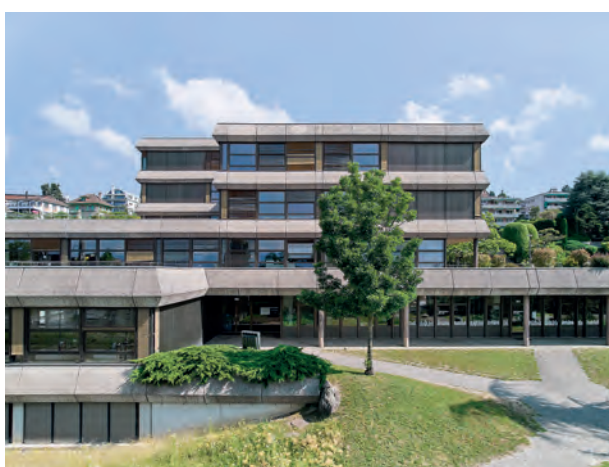
Collège Arnold Reymond, façade sud
