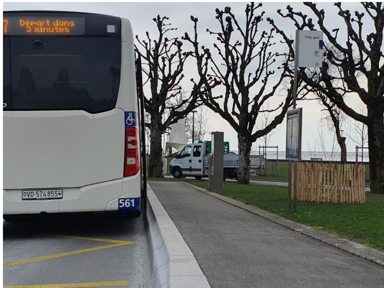
Figure 1 : sept arrêts seront mis aux normes et permettront un accès facile (sans marche) aux bus (photo : DTSI)
