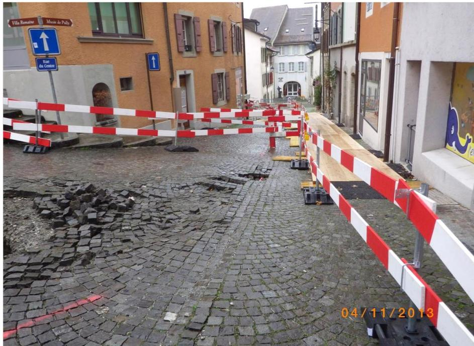
Cette fuite a occasionné d'importants dégâts sur la chaussée de la rue du Midi jusqu'au ch. des Osches. Les pavés ont été soulevés à plusieurs endroits, créant des "vides" importants entre ces derniers et la fondation de la chaussée.
