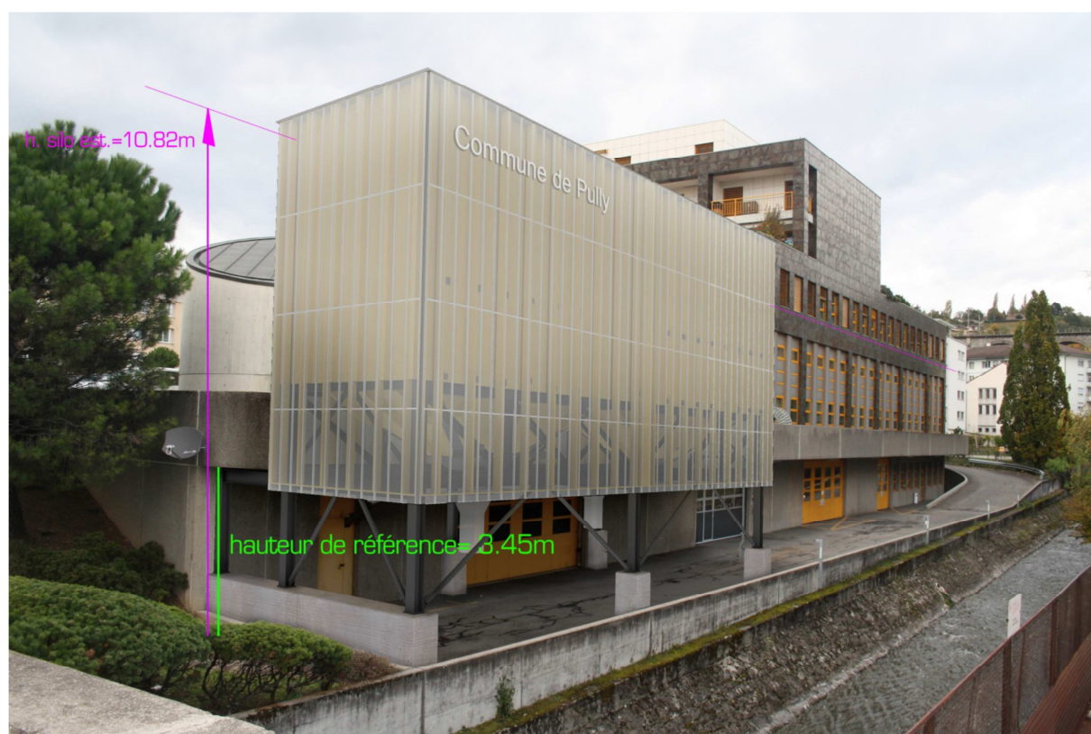
Silo à sel « habillé » de l'enveloppe de couverture
