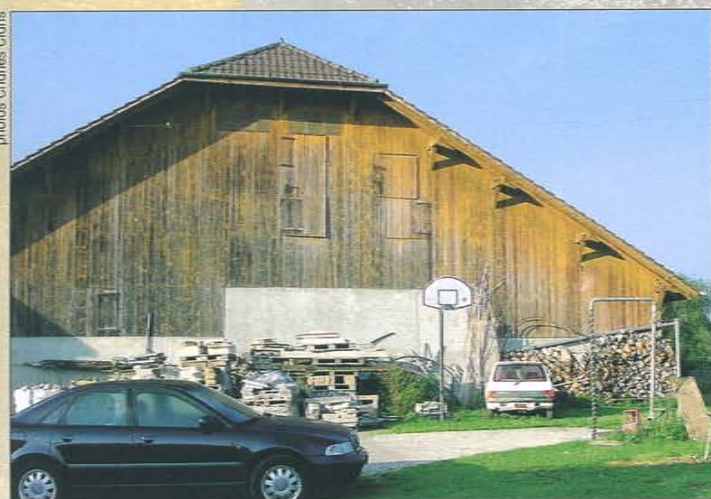
Un bâtiment ayant perdu sa vocation agricole.
