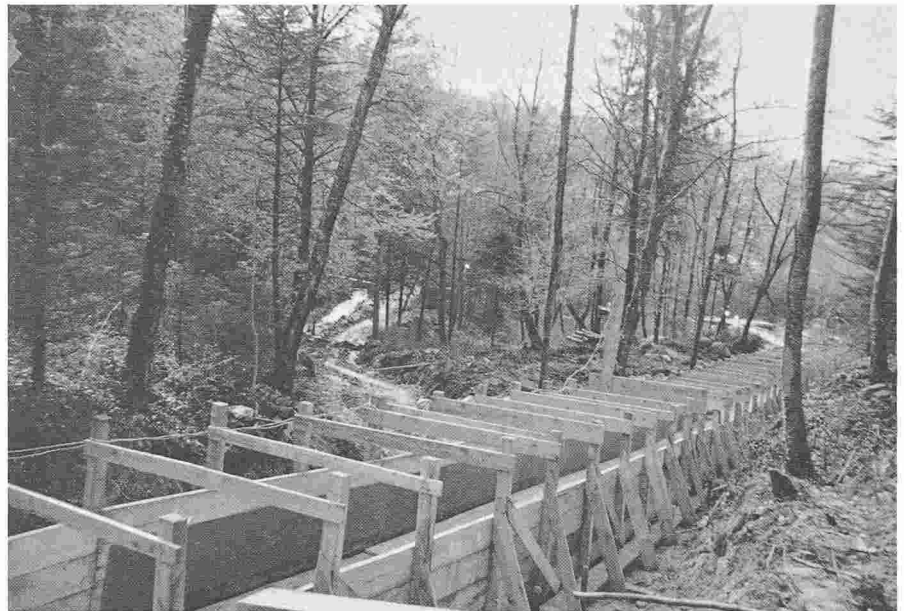
Fig. 3. - Mesure d'urgence, le chenal provisoire.
