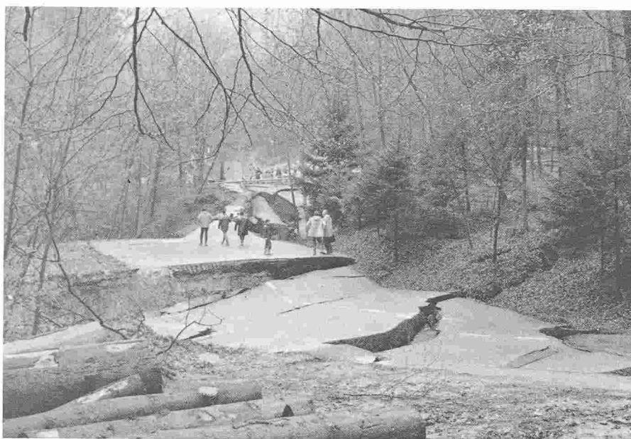
Fig. 1. – La route cantonale 773d, le 21 avril 1983.
