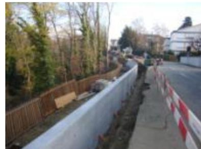
Voile de soutènement en béton
