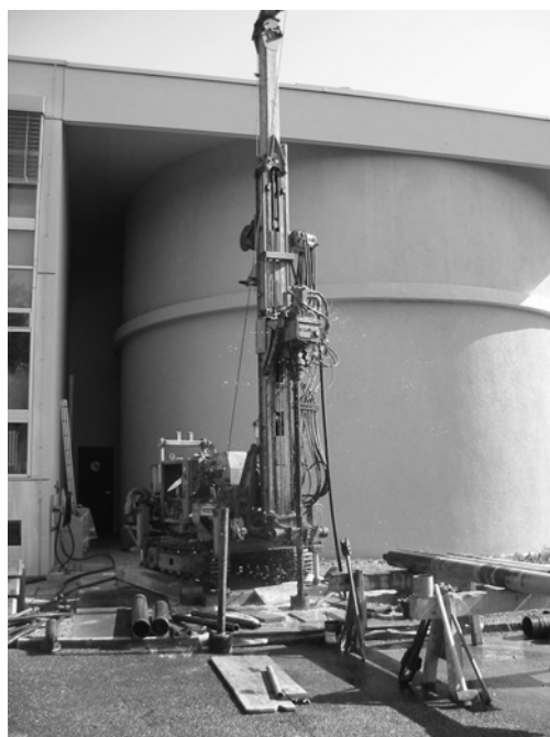
Forage du sol pour le contrôle de la nappe phréatique
