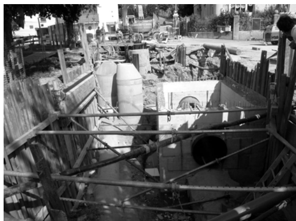
Construction du déversoir d'orages à l'av. des Alpes, 25 septembre 2008
