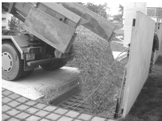
Approvisionnement du chauffage à bois en plaquettes du complexe scolaire des Alpes
