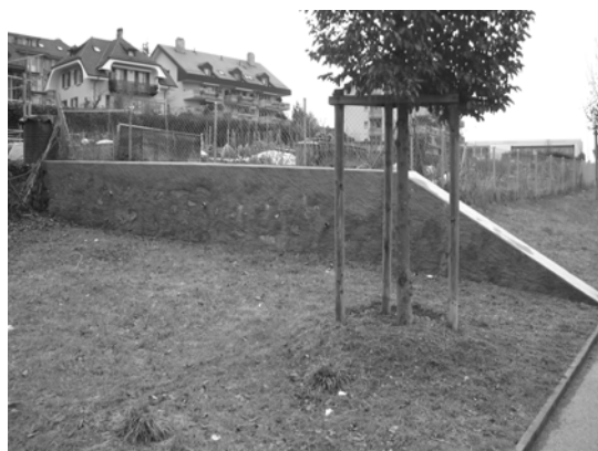
Réalisation d'un mur de soutènement aux jardins familiaux des Alpes
