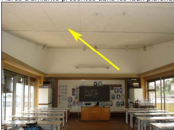
Faux plafonds des salles de classe
