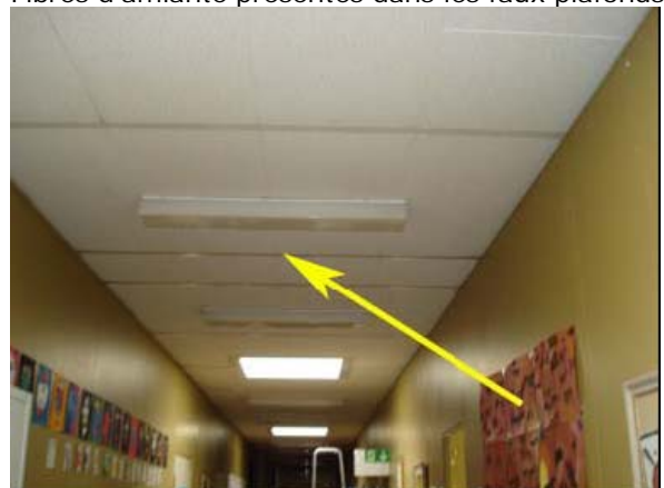
Faux plafonds des salles de classe
