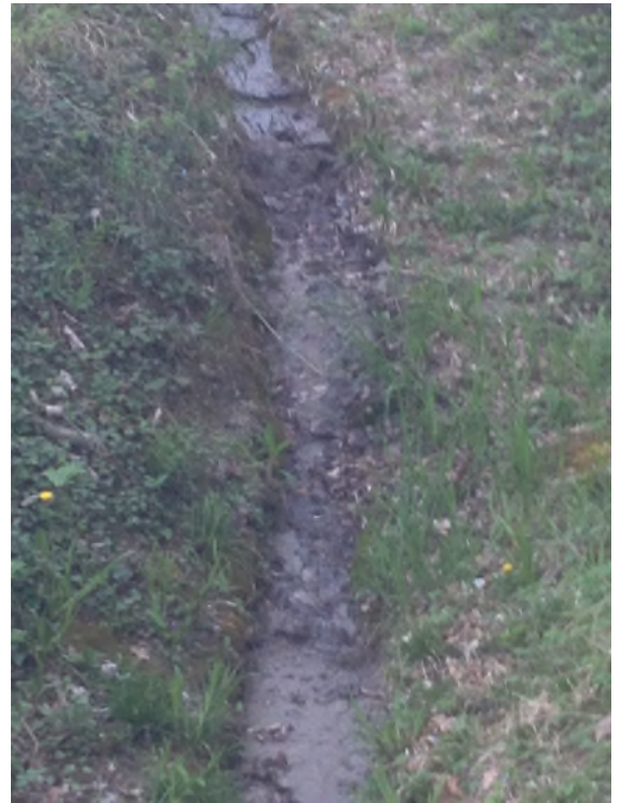
Figure n°3 : restes d'une coulisse dans le terrain sous la RC
