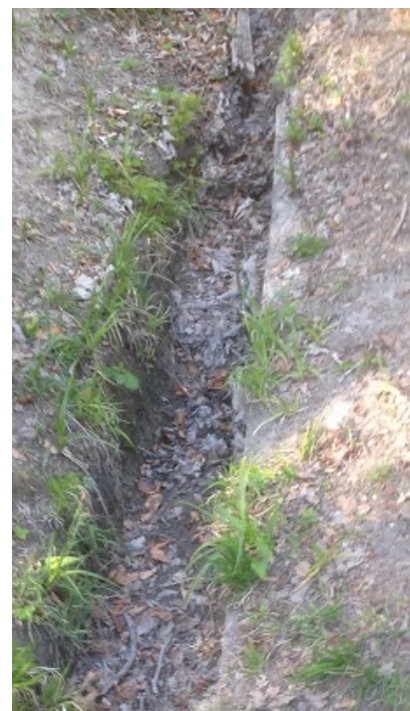
Figure n°5 : restes d'une coulisse
