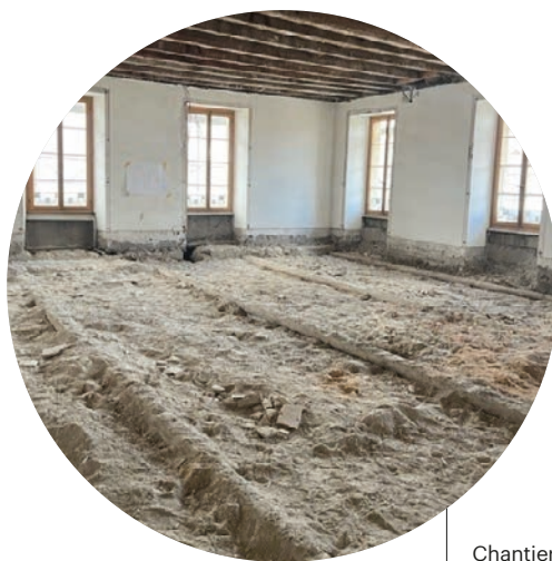
Chantier du Prieuré
