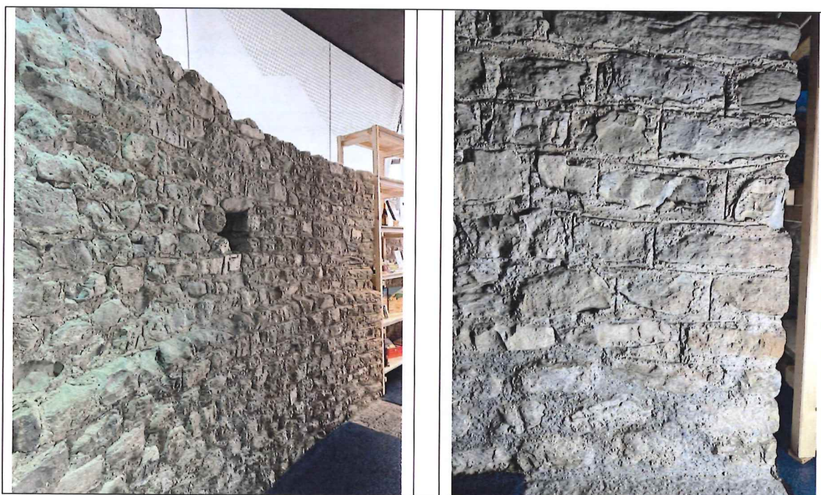
Vues générales du mur à l'arrière de la peinture, avec le mur en élévation, le magnifique appareillage régulier et les joints incisés romains.
